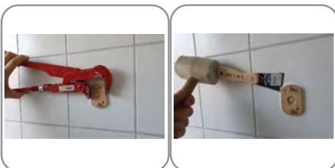
Der Klebeadapter lässt sich am besten mit einer Rohrzange drehend ablösen.
